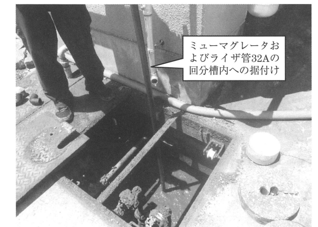
写真7 回分槽の汚水を空にせず機器の据付
