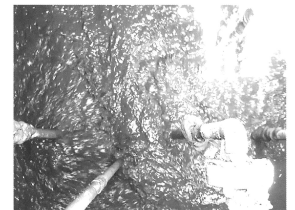
写真 11 回分槽内のばっ気攪拌状況
